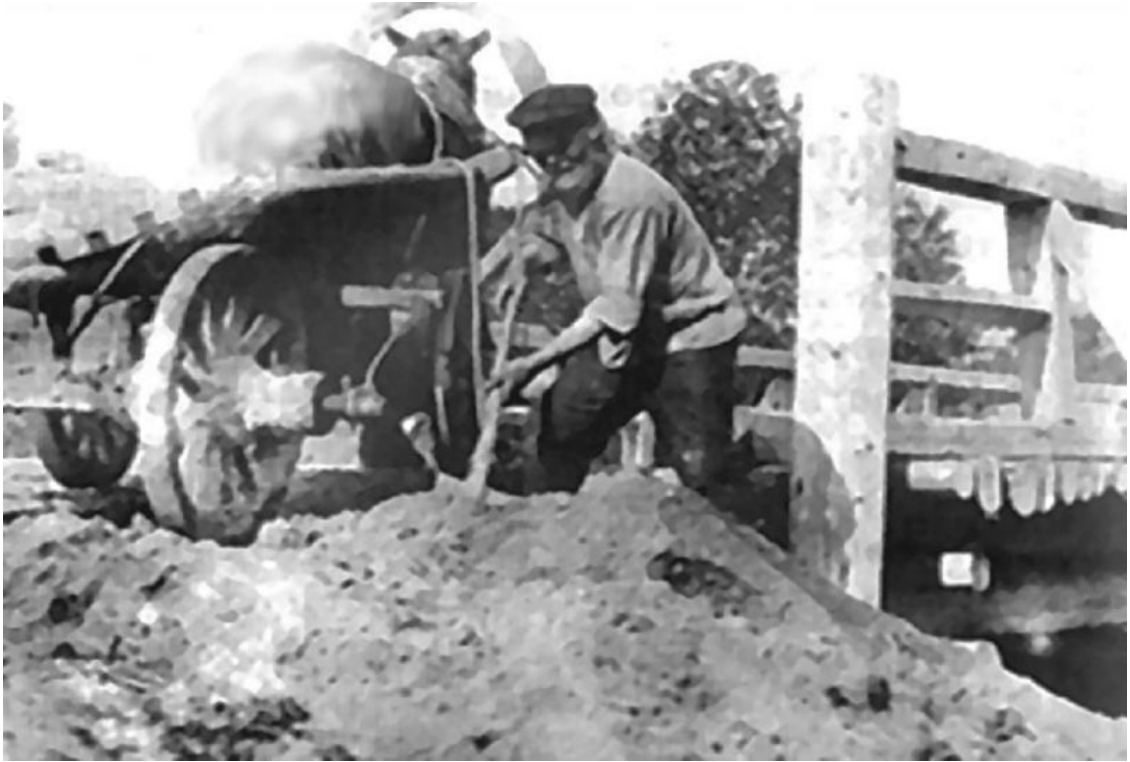
Рис. 16. Конная грабарка. Выгрузка грунта производилась с помощью специального рычага для опрокидывания «кузова» (пробраза нынешнего автомобиля-самосвала).
