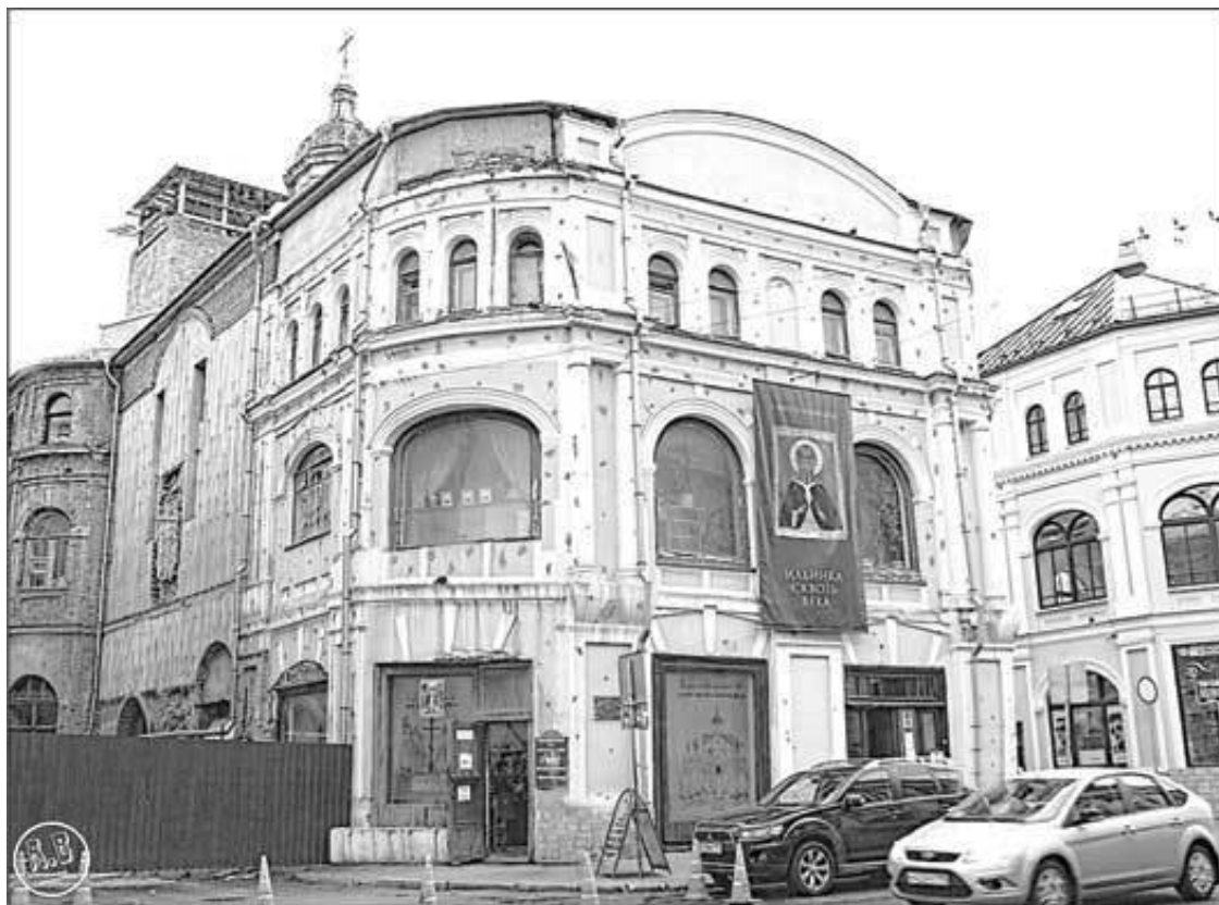
Церковь Илии Пророка в Теплых рядах. Современная фотография
