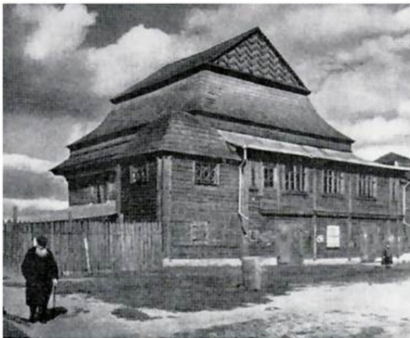
Средневековая синагога (здание не сохранилось). Фото из источника в списке литературы [1]
