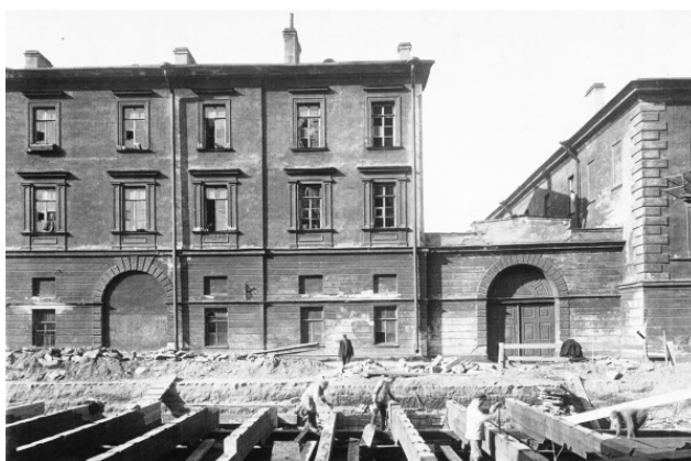
Разборка Перекрытия на канале Грибоедова. Фото 1926 г.
