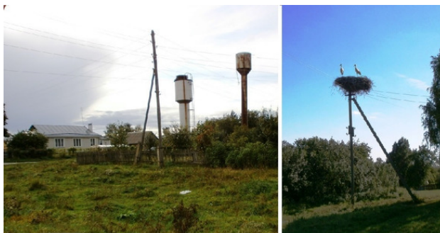
Гнёзда аистов: на левой водонапорной башне и на столбе ЛЭП
