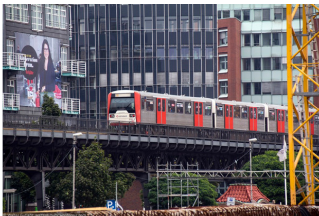
Рис.3. Наземная линия метро. Гамбург
