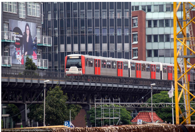
Рис.3. Надземная линия метро. Гамбург
