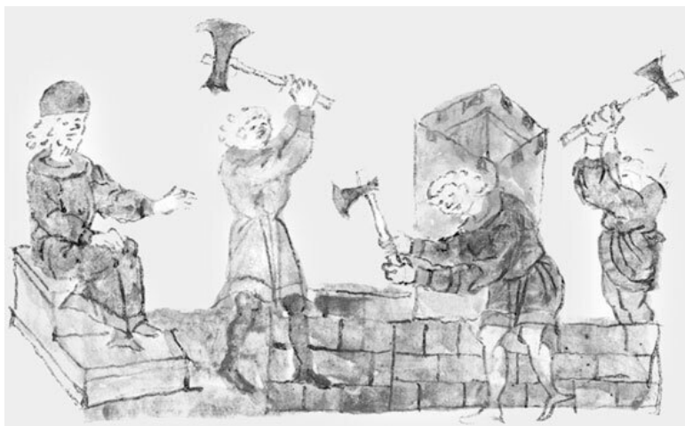
Строительство Успенского собора во Владимире по
