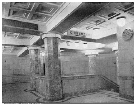
«Красносельская». Балкон с лестницами
