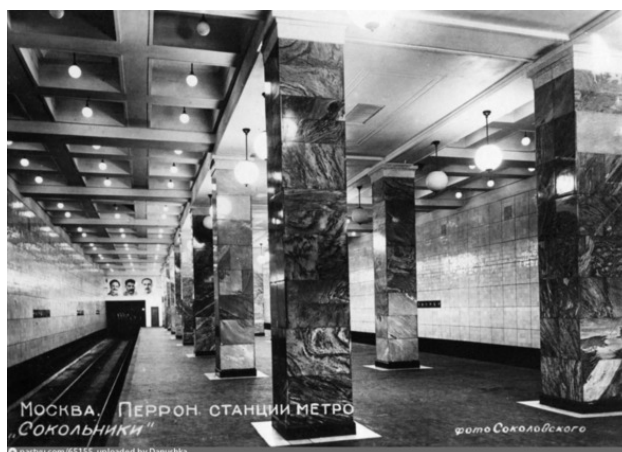
«Сокольники». Общий вид зала
