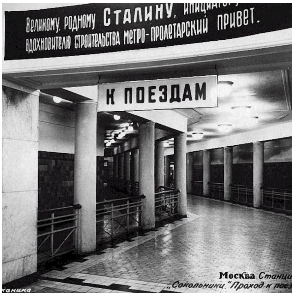
«Сокольники». Подходной коридор
