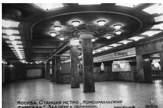
«Комсомольская». Северный аванзал после 1952 г.
