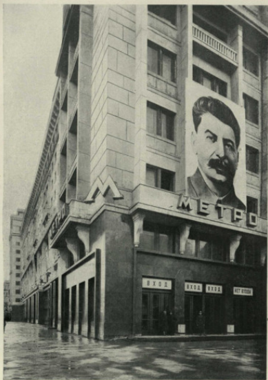
47. Станция ОХОТНЫЙ РЯД. Наземный вестибюль (здание гостиницы «Москва»). Авторы: зав. арх. Щеглов А. В., арх. Савельев А. Н., Старков О. А.
