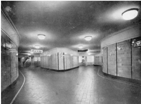
«Дзержинская». Подходной коридор
