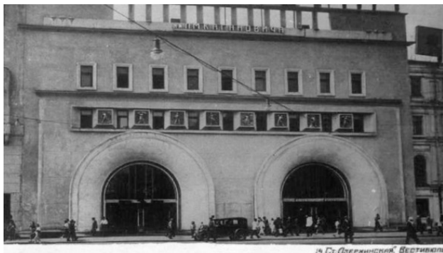
«Дзержинская». Наземный вестибюль
