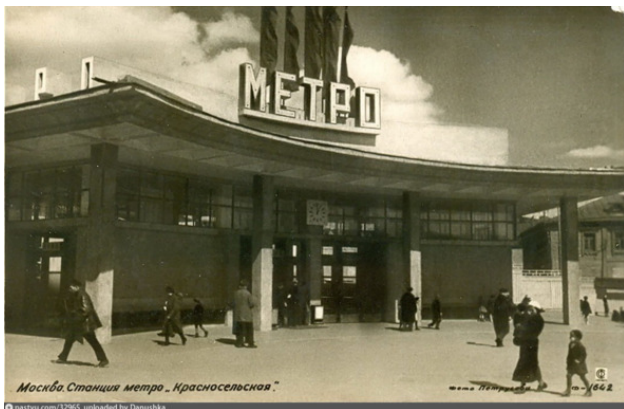
«Красносельская». Наземный вестибюль
