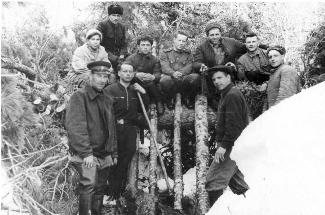
Строительство плотины в долине ручья. 1-й ряд: Ортюков, Дилевич, Кузнецов; 2-й ряд: Аскинадзи, Суворов.
