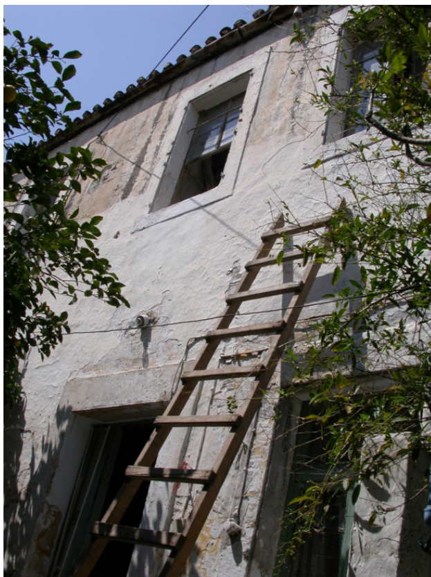
Дом Василия, каким он был до ремонта.
