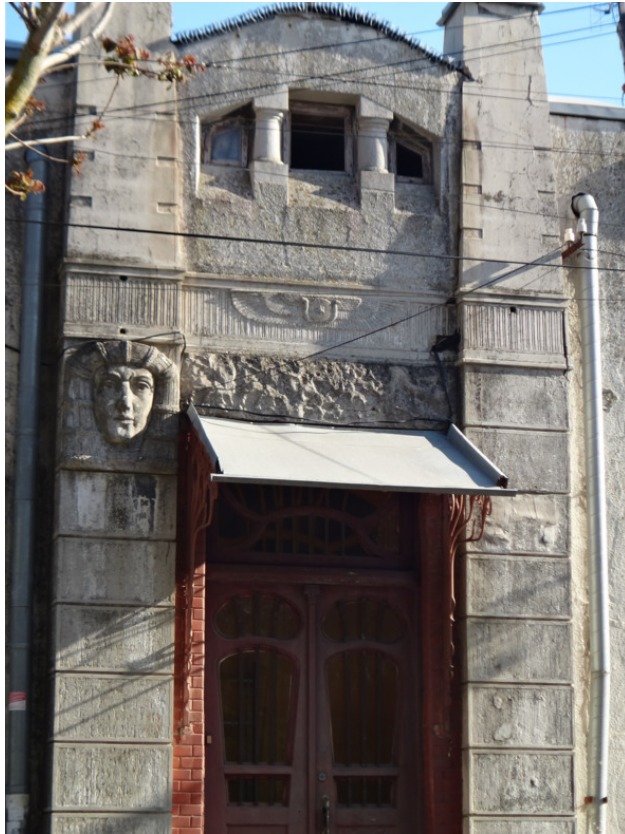
Входной портал собственного дома архитектора А. Л. Генриха с декором в египетском «вкусе» (фото автора, 2019 год)
