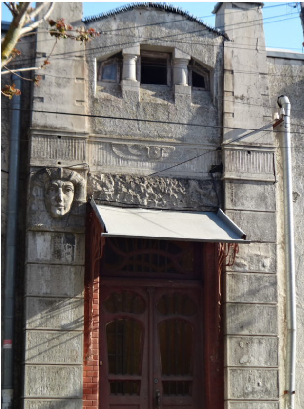
Входной портал собственного дома архитектора А. Л. Генриха с декором в египетском «вкусе» (фото автора, 2019 год)
