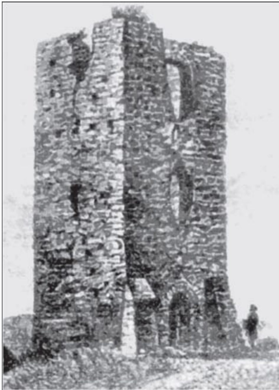
Руины Даниловой башни под Холмом
