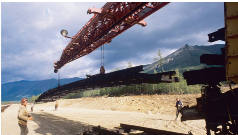
Строительство Байкало-Амурской магистрали
