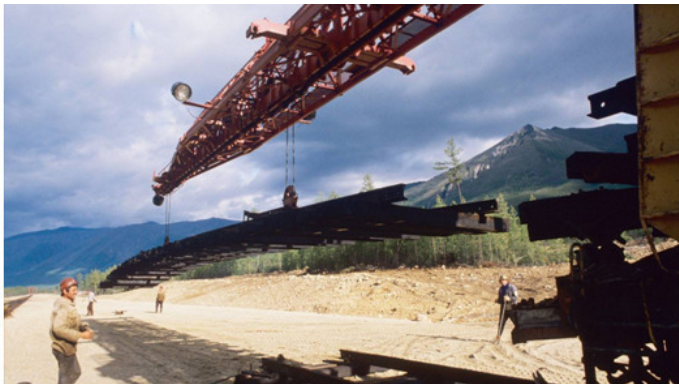
Строительство Байкало-Амурской магистрали
