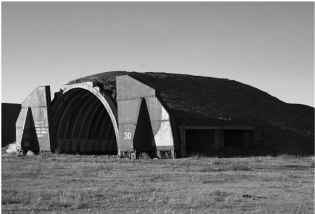
Аэродром Чойбалсан, железобетонное укрытие для военного самолета. Современный вид.
