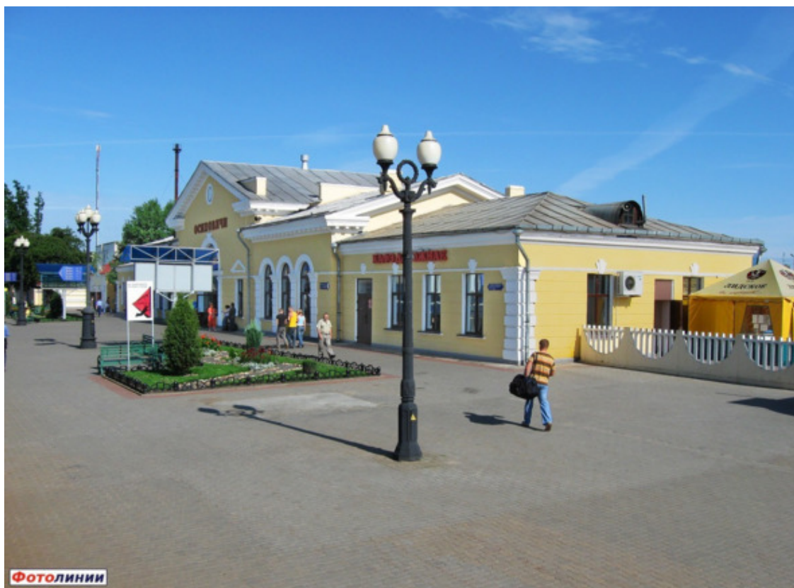
Пассажирское здание, станция Осиповичи I. 29.07.2009
