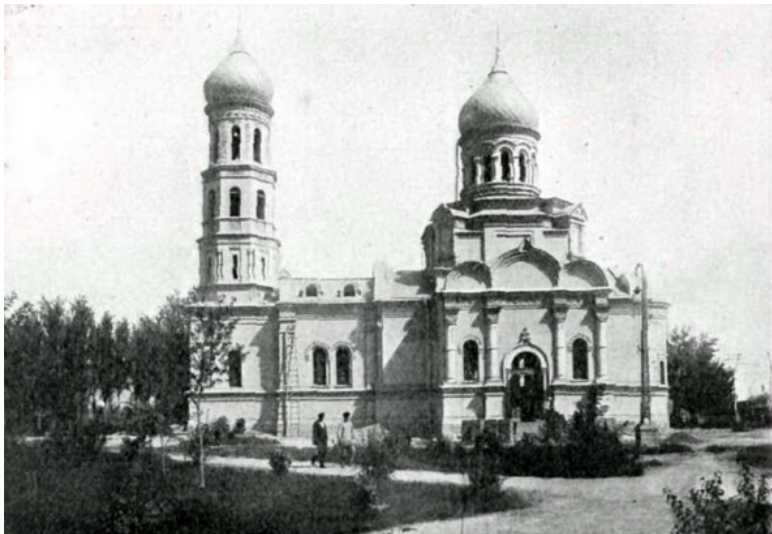
Церковь Благовещения. Построена в 1899, снесена в 1920-х.
