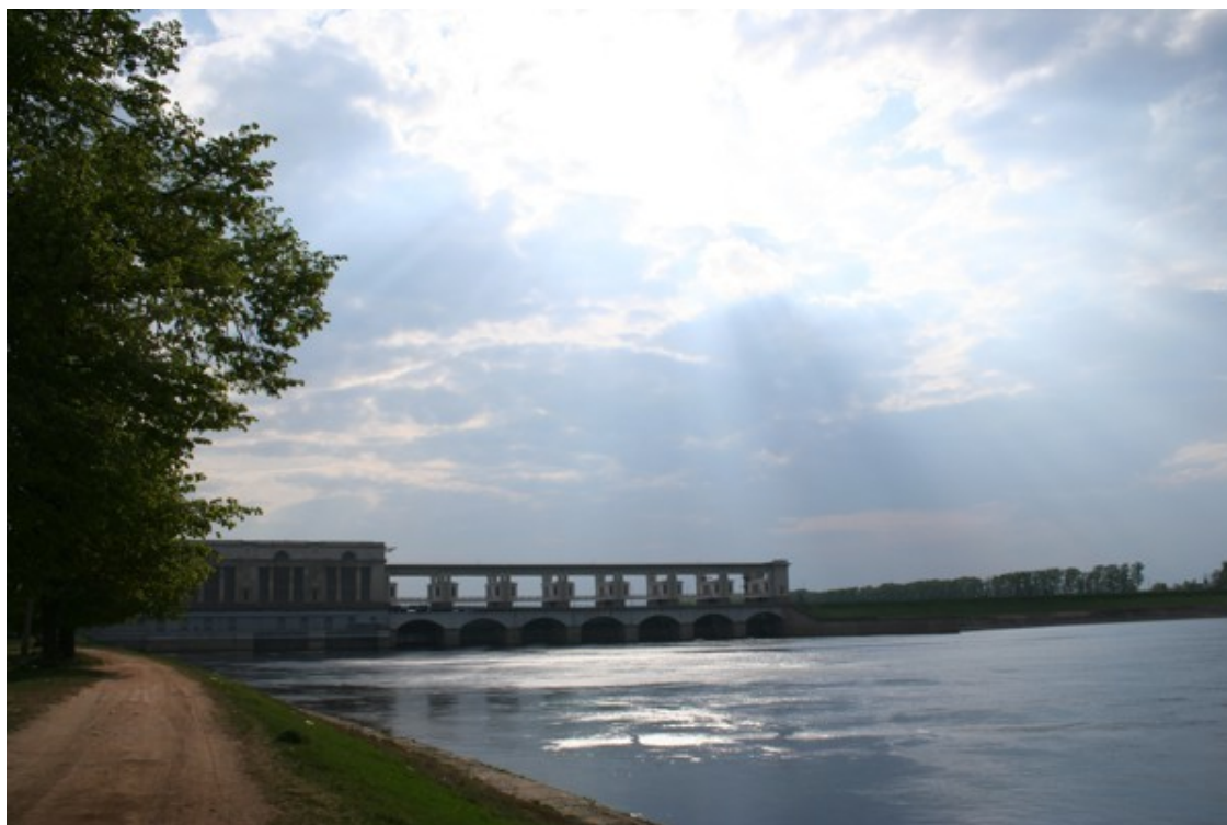
Угличская ГЭС, г. Углич (Ярославская обл.)
