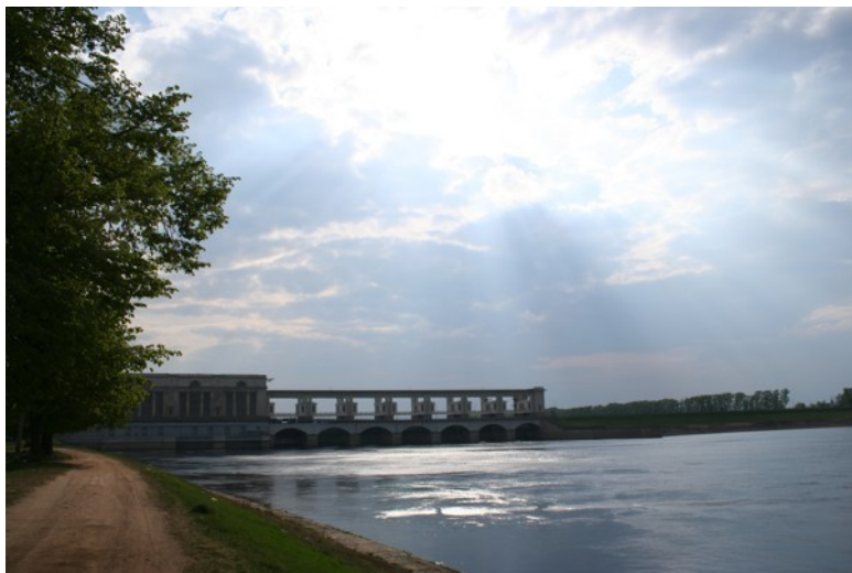
Угличская ГЭС, г. Углич (Ярославская обл.)
