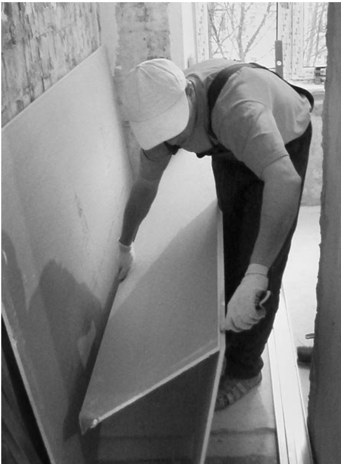
Рис. 3.1. Прорезанный гипсокартон легко ломается по срезу
