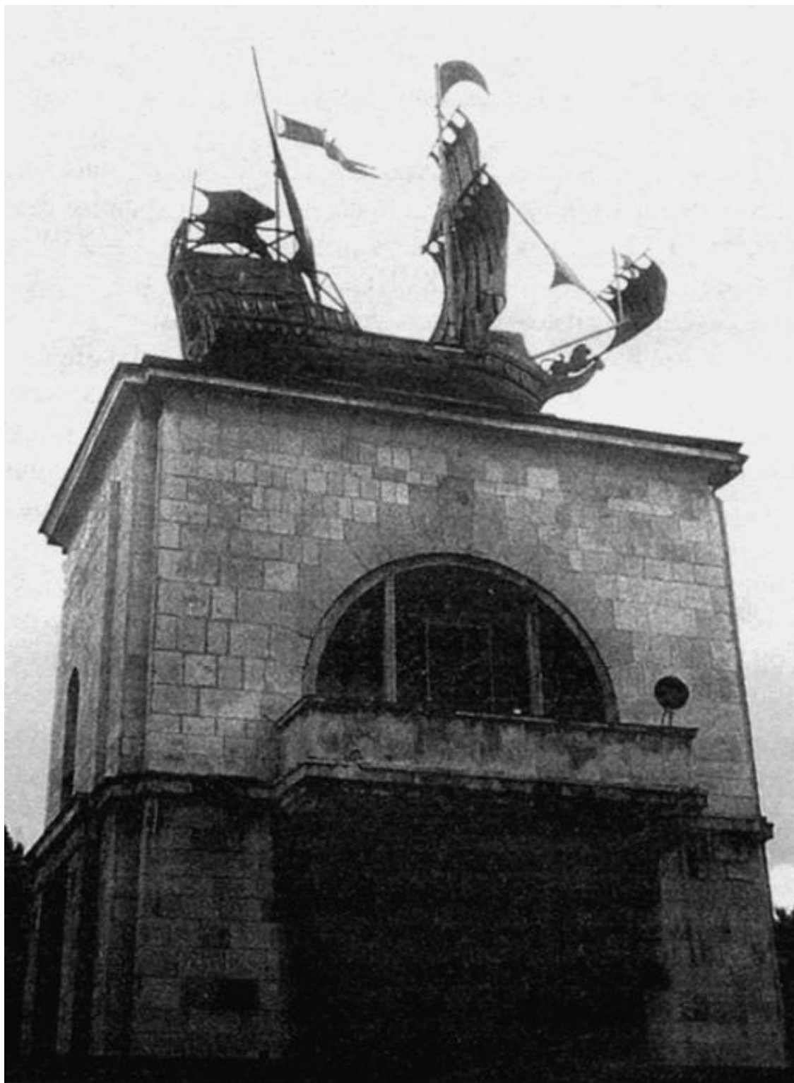
Шлюз № 3 в районе Яхромы
