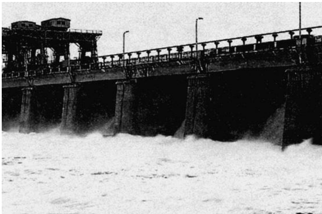
Плотина в районе Дубны
