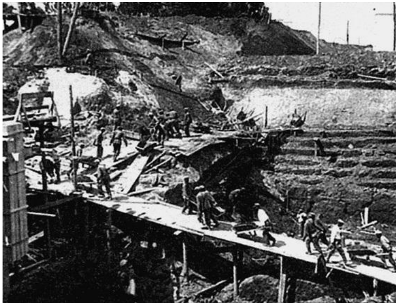
На строительстве канала Москва-Волга
