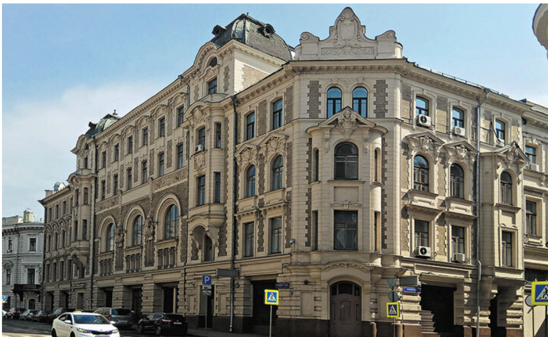
Дом Серпуховского городского общества. Москва, Ильинка ул., 12. Архитектор Роман Клейн
