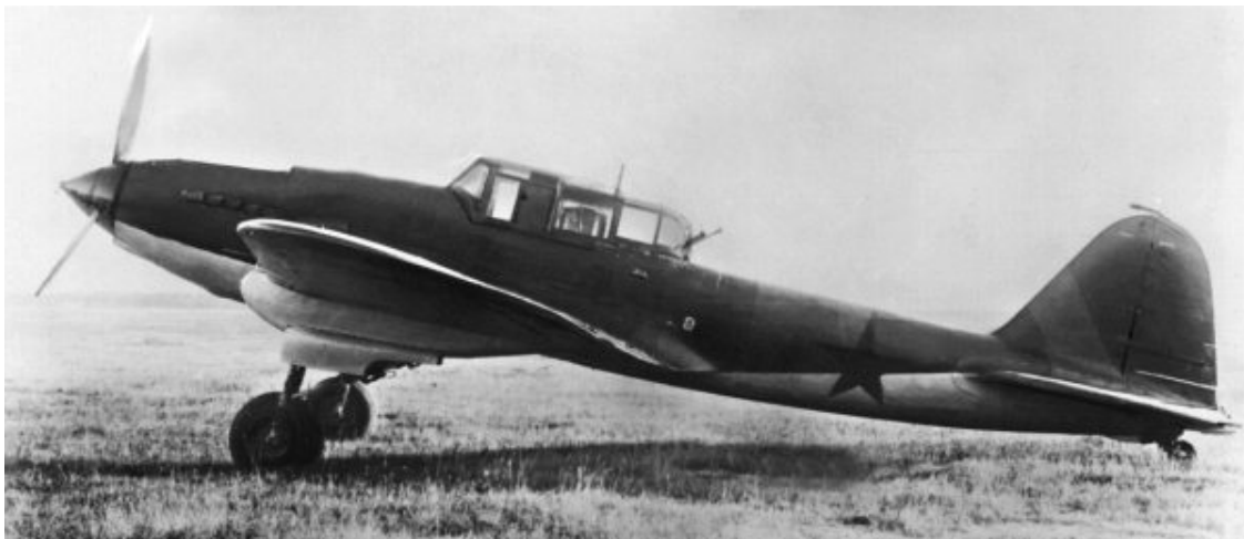
Двухместный Ил-2 АМ-38 (зав. № 897) с пулеметом ЛЛ1КАС на турели производства завода № 30. Государственные испытания, октябрь 1942 г.
