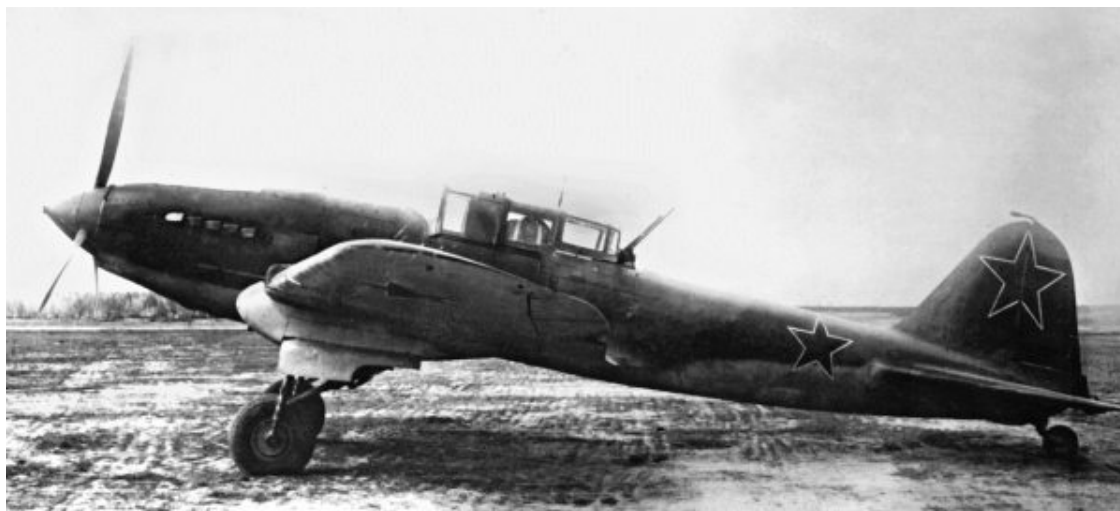
Серийный самолет Ил-2 с мотором АМ-38ф
