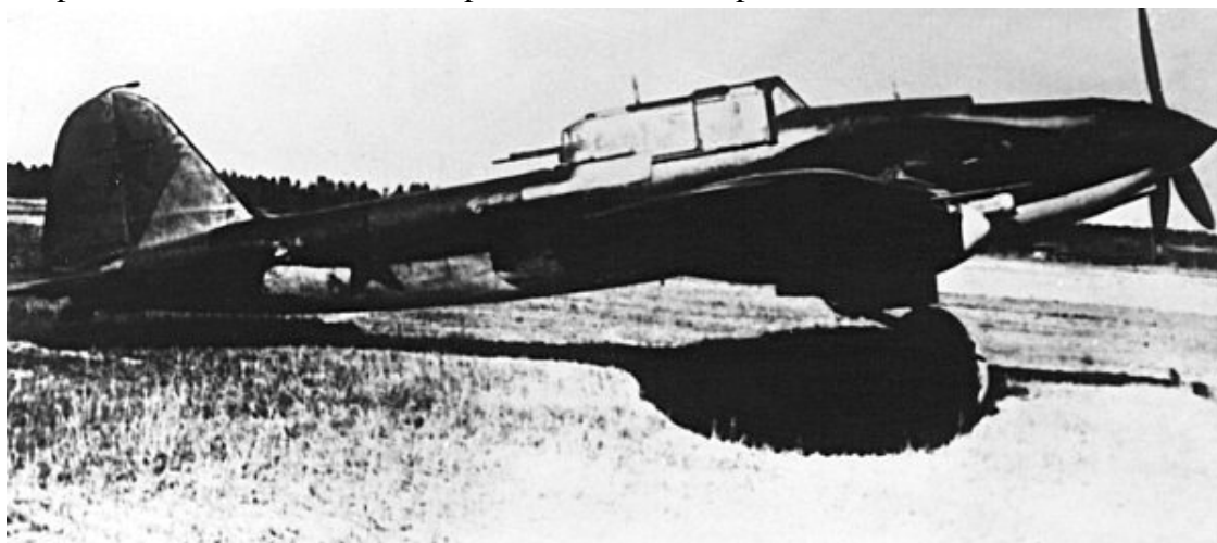
Двухместный Ил-2 АМ-38 (зав. № 887) с пулеметом УБТ на турели производства завода № 30. Государственные испытания, октябрь 1942 г.
