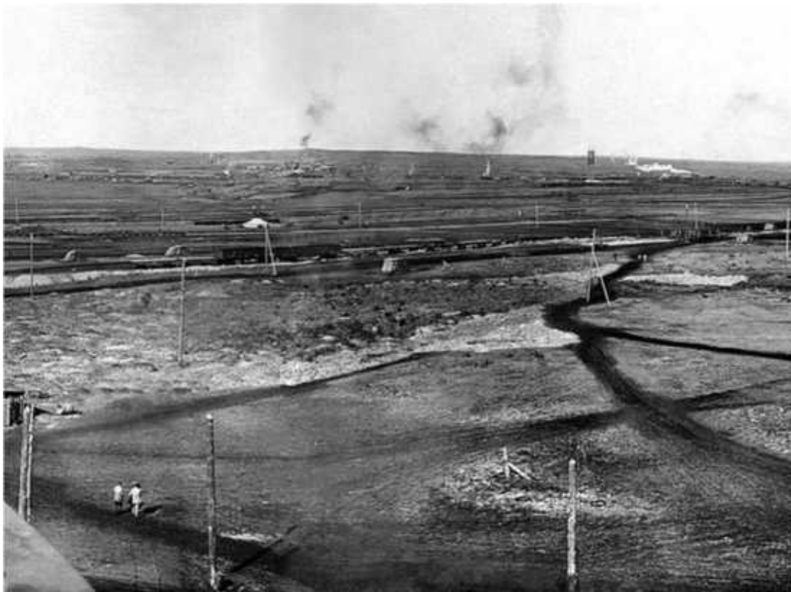
Панорама строительства Магнитогорского металлургического комбината, 1930 г.
