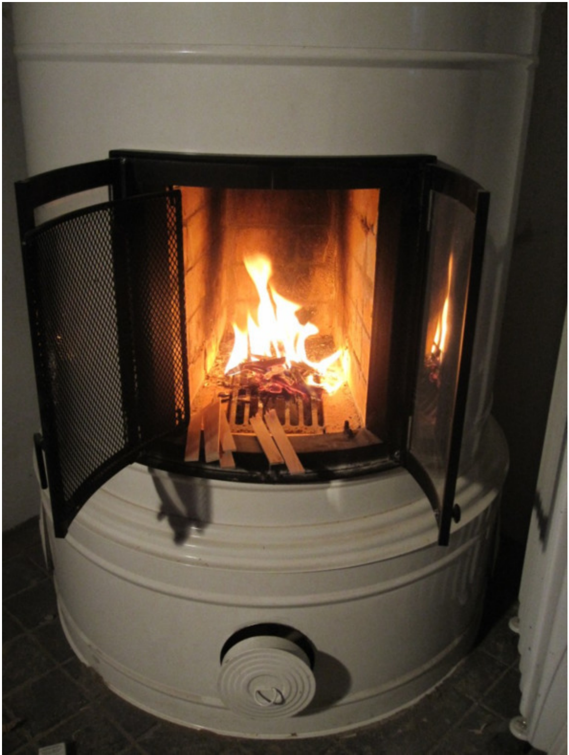
Колосниковая топка в круглой печи.
