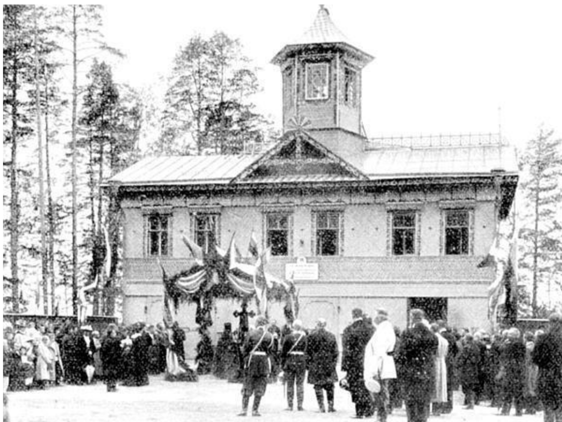
Торжественный молебен перед зданием новой пожарной дружины в Лигово. Фото К. Буллы, 1903 год
