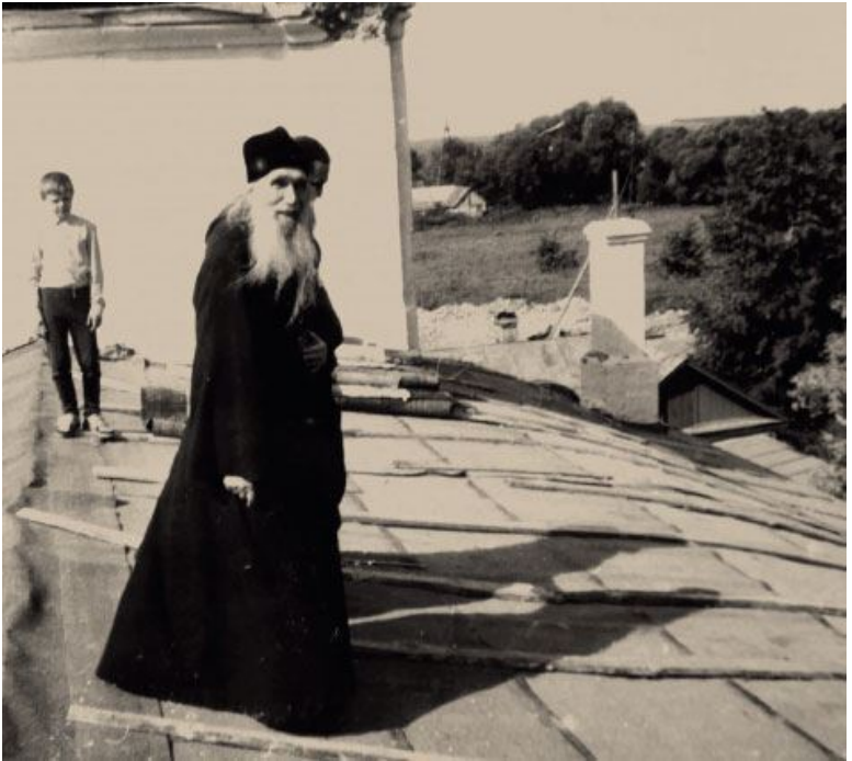
Архимандрит Кирилл на крыше храма во время восстановительных работ
