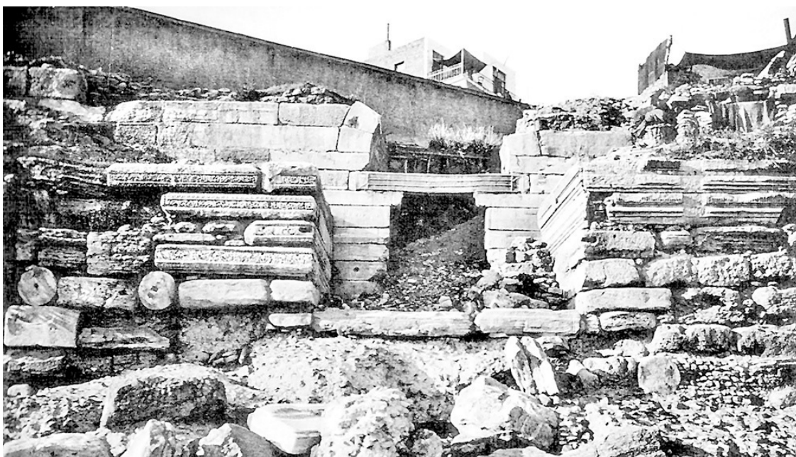
Морская стена под Большим дворцом. Фотография XIX в.
