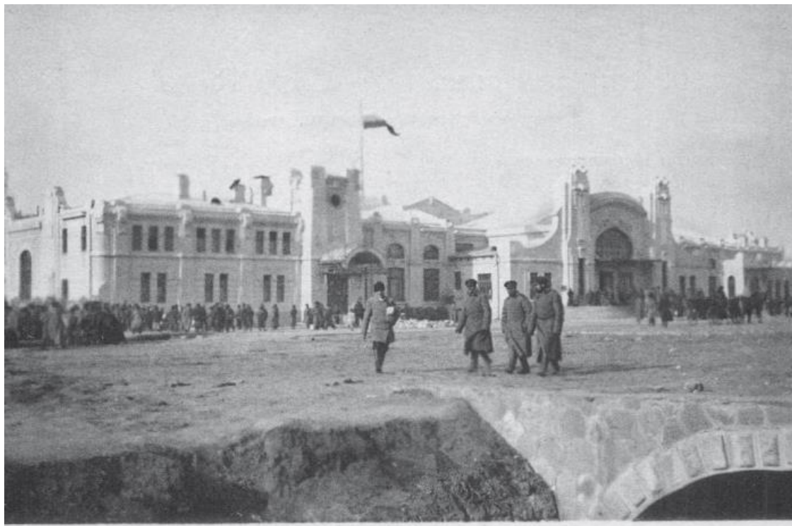
Железнодорожный вокзал в Харбине
