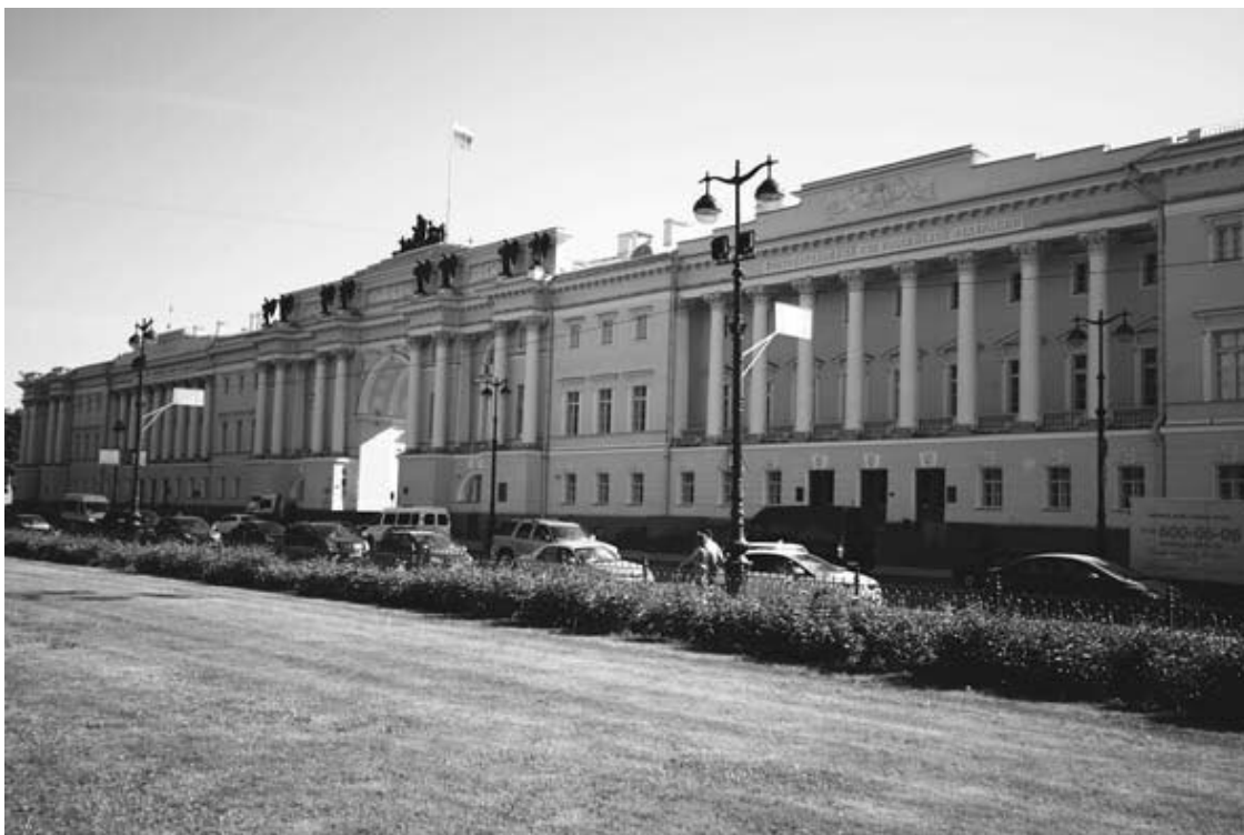
Здание Сената и Синода, Сенатская площадь
