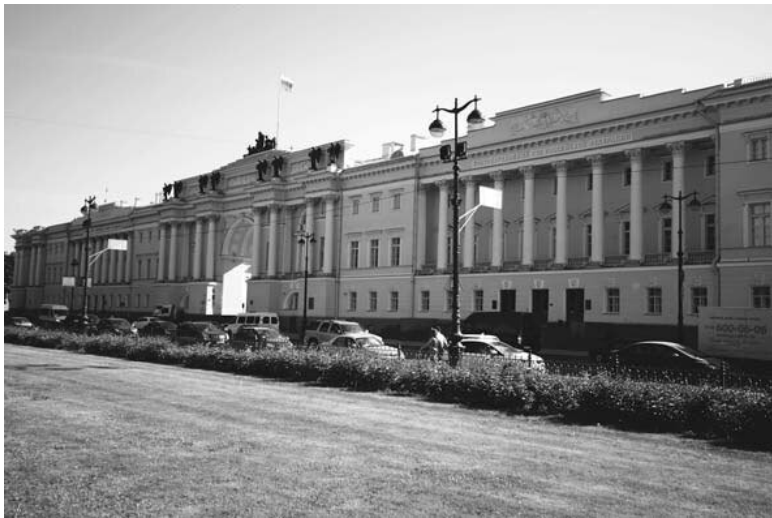
Здание Сената и Синода, Сенатская площадь
