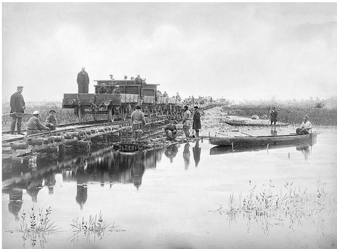
Строительство железной дороги. Фото 1880—1890-х годов
