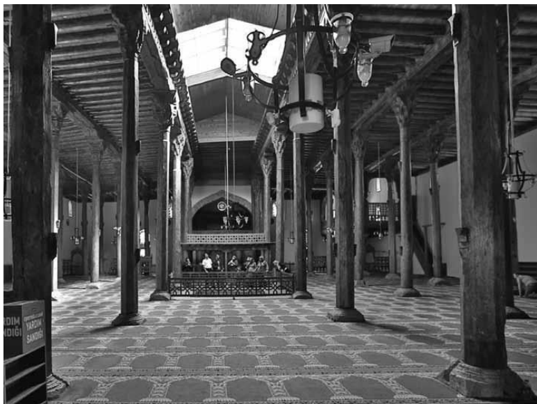
Эшрефоглу-джами, Бейшехир. Центральный неф. Вид с севера
