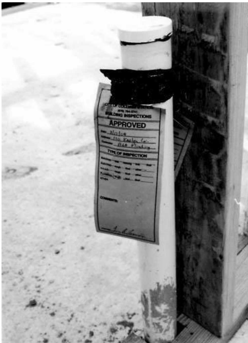
Рис. 2.2. После принятия первого этапа сантехнических работ на месте проведения работ вешается бирка
