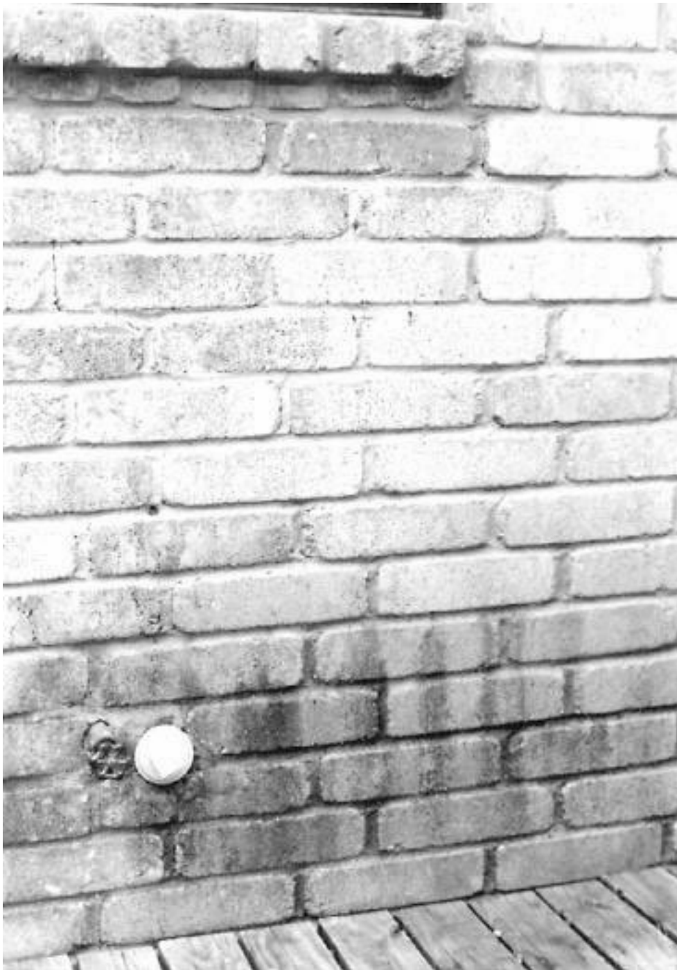
Рис. 1.14. Доступное расположение ревизии с заглушкой для прочистки кухонного слива
