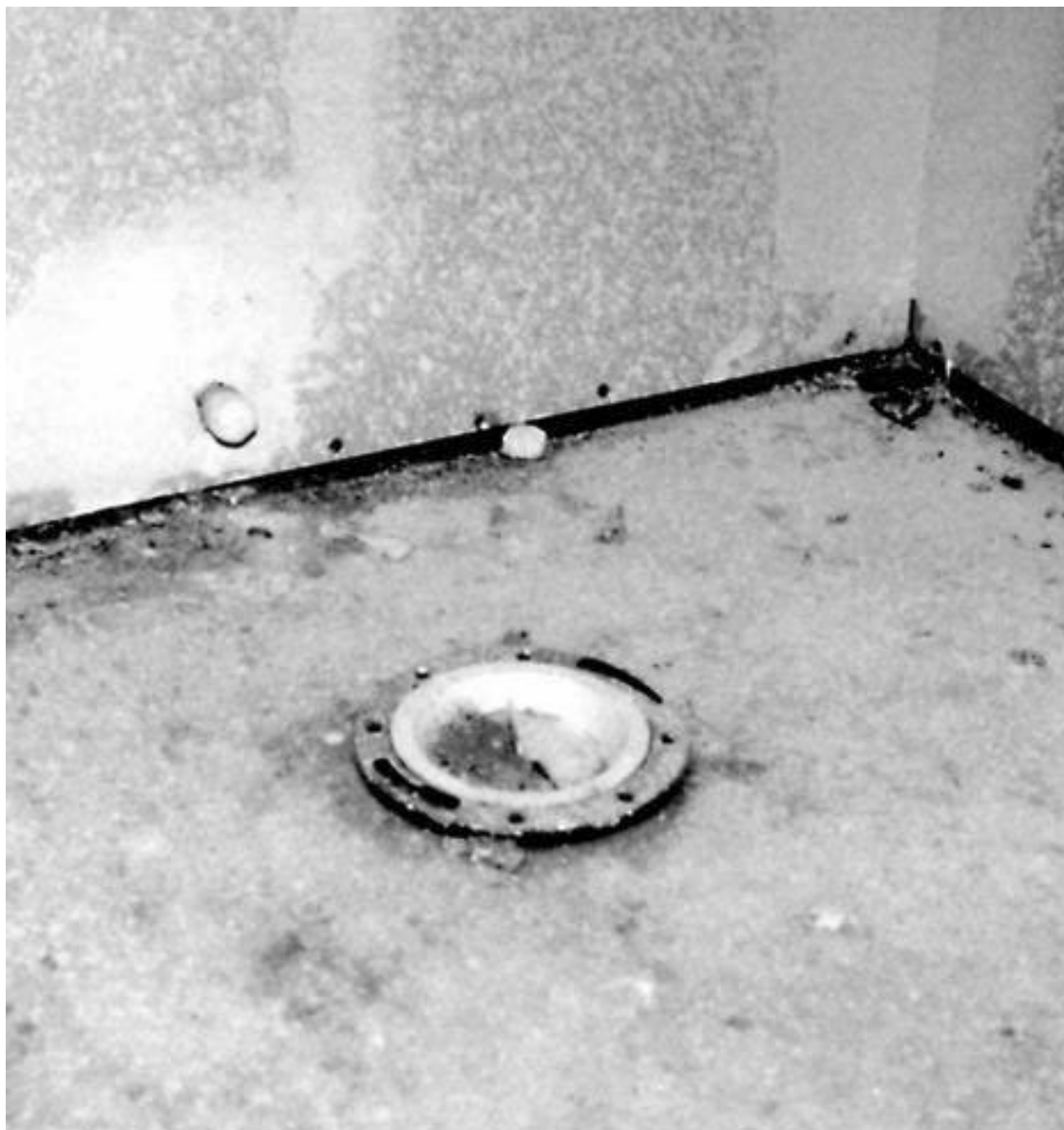
Рис. 2.4. Трубы обрезаются для того, чтобы можно было установить монтажные кронштейны
