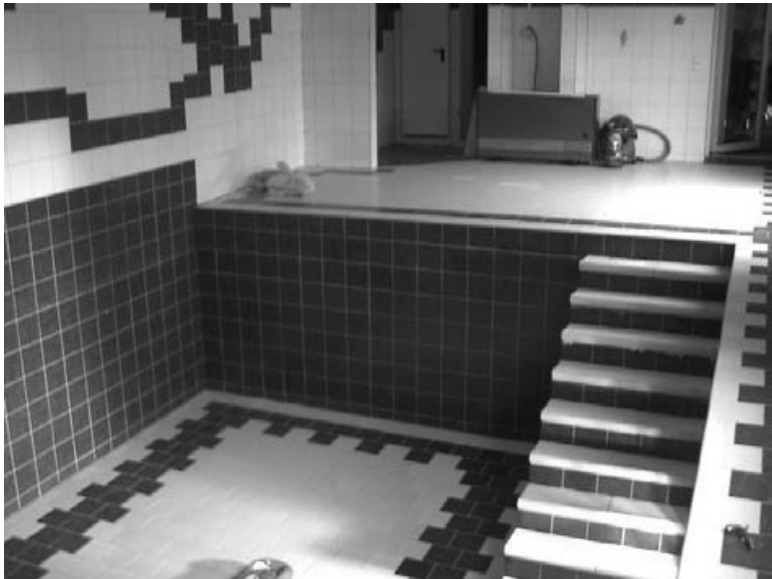
Рис. 2.1. Бассейн, облицованный плиткой
