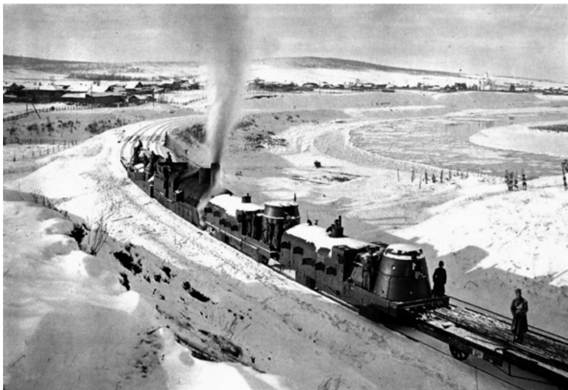
Бронепоезд на мосту через р. Кузьмиха
