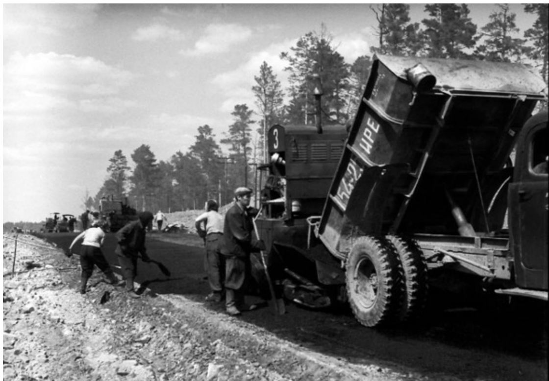
Строительство Байкальского тракта
