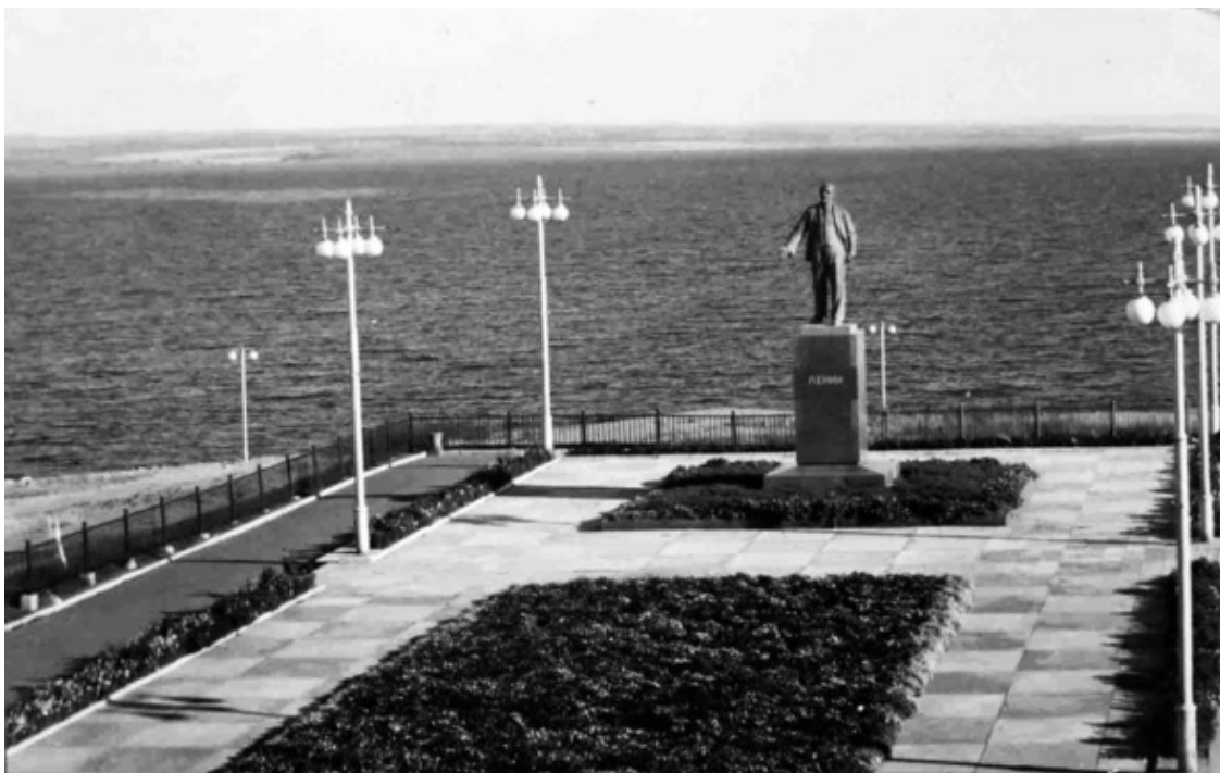
Памятник В. И. Ленину на Иркутской ГЭС
