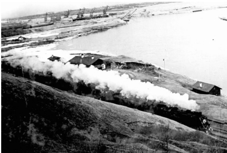
Блокпост Ершовский и вид на строительство Иркут-
