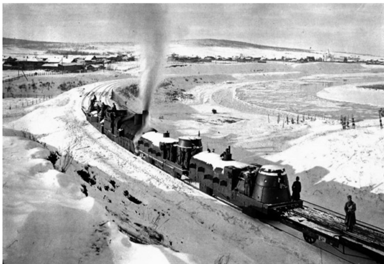
Бронепоезд на мосту через р. Кузьмиха
