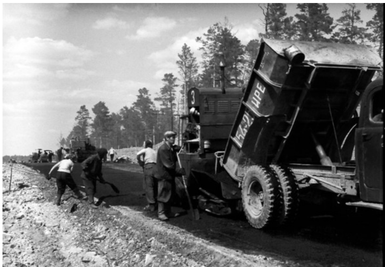
Строительство Байкальского тракта
