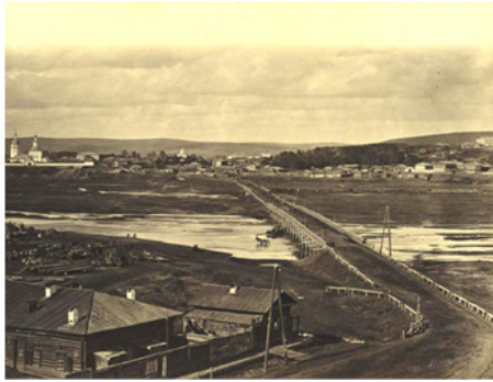
Знаменский мост через Ушаковку
