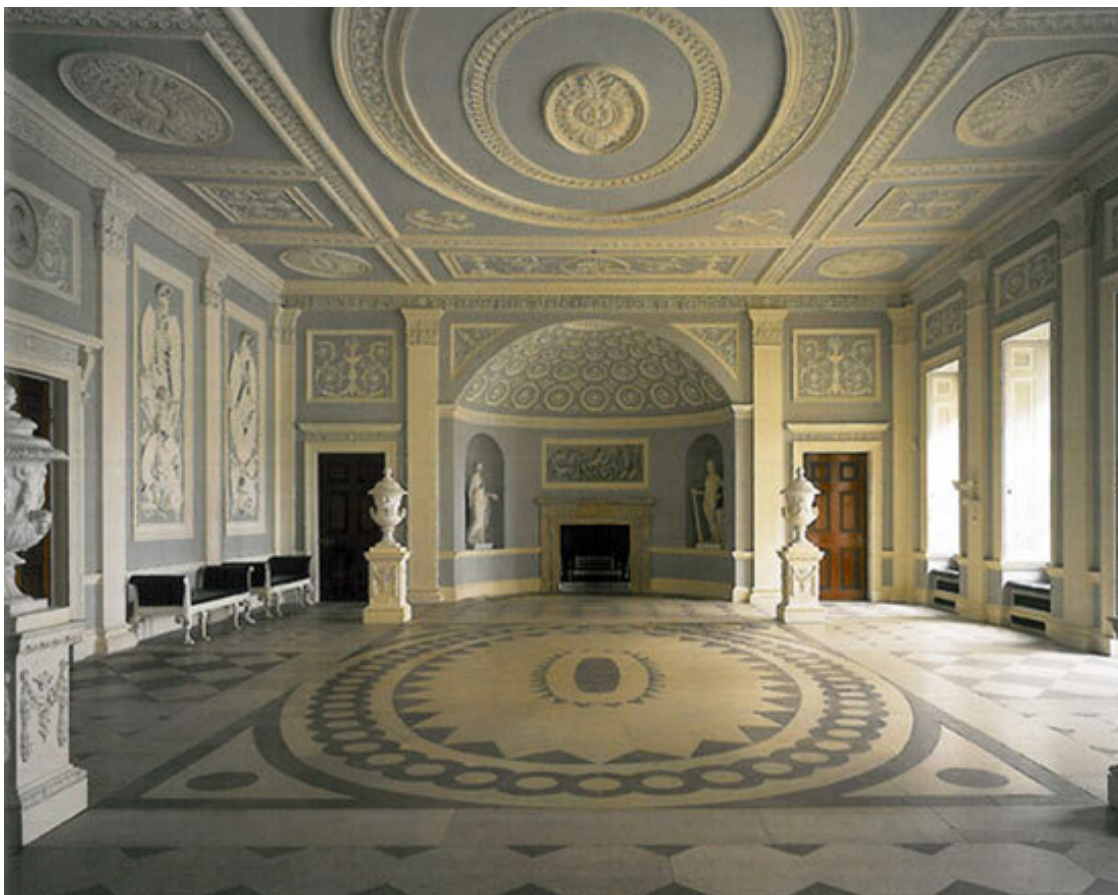
Ил. 13. Регулярно приставленные к стенам ордерные пилястры. Вестибюль в Остерли-парк (Англия). Арх. Р. Адам. 1767 г.
