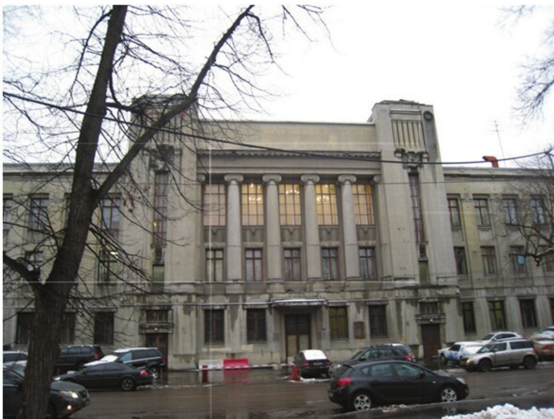
Здание Университета им. А.Л. Шанявского
