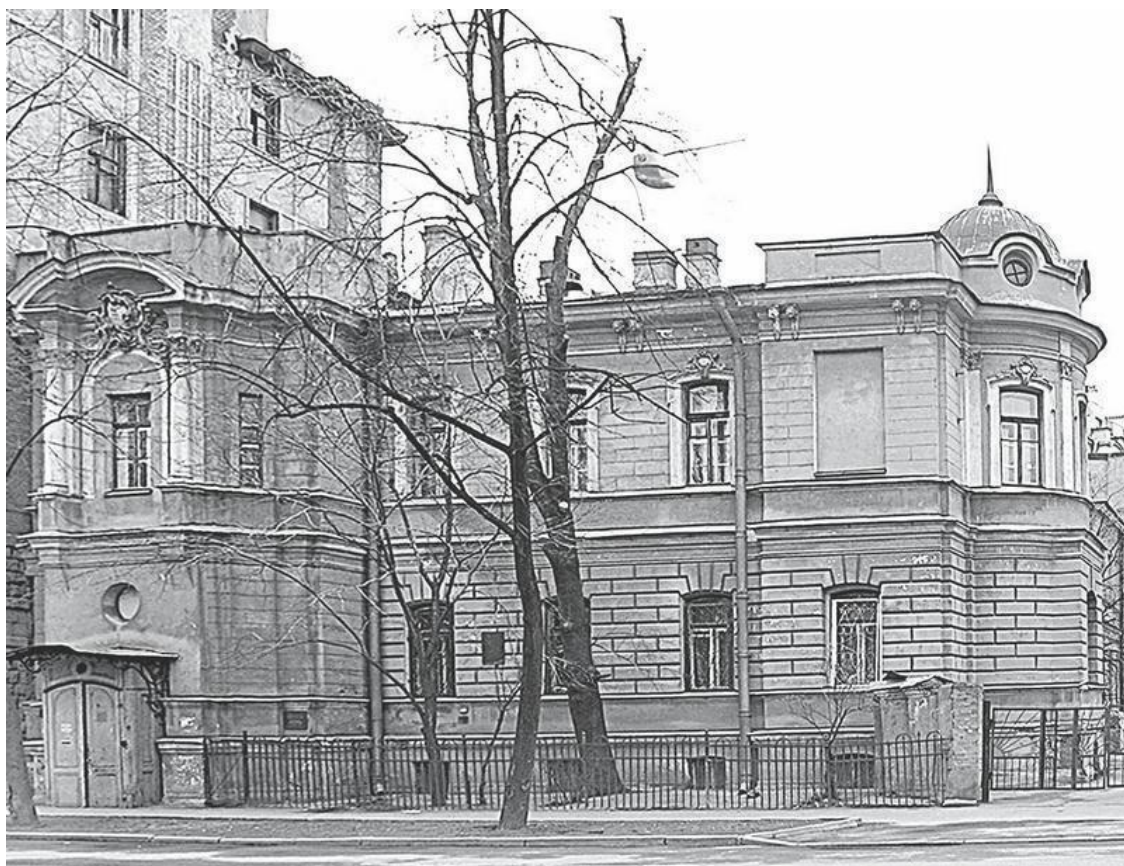
Алексеевская ул., 12. Особняк Ф.Г. Козлянинова. Фото 2000-х гг.
