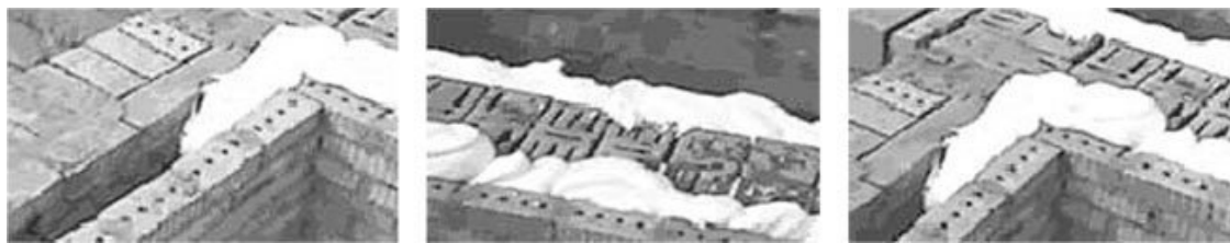
Рис. 1.6. Использование заливочного пенопласта
