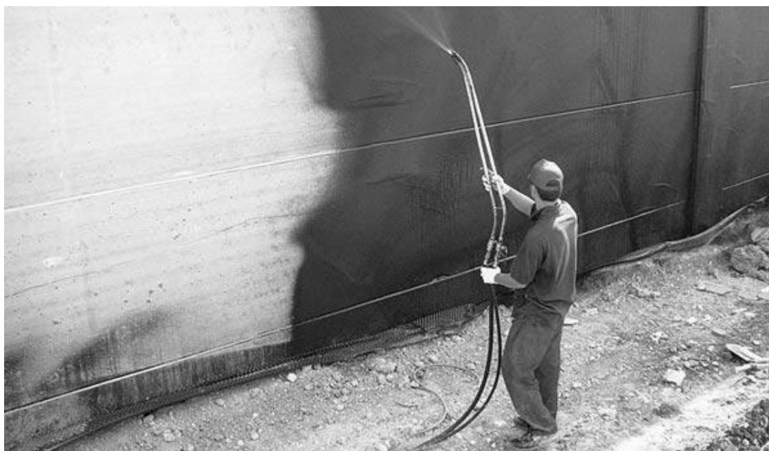
Рис. 1.7. Напыление жидкой резины
