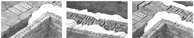
Рис. 1.6. Использование заливочного пенопласта
