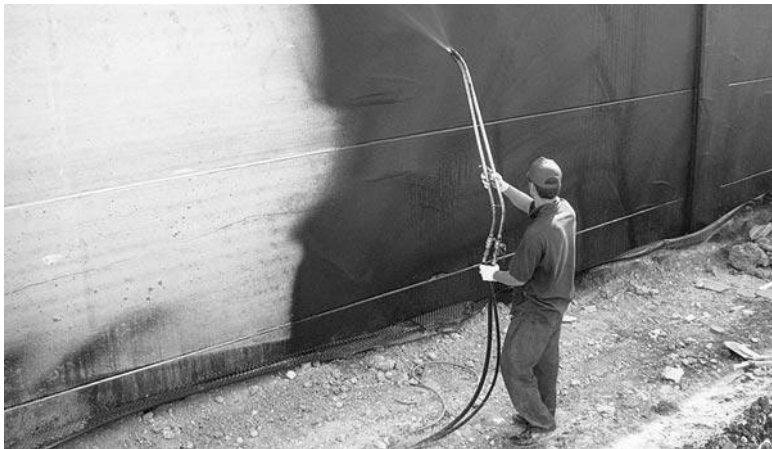
Рис. 1.7. Напыление жидкой резины
