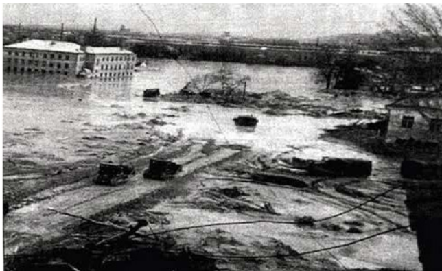
Рис. 1.1. Последствия прорыва дамбы гидроотвала «Бабий яр» в Киеве в 1961 г. [15].
