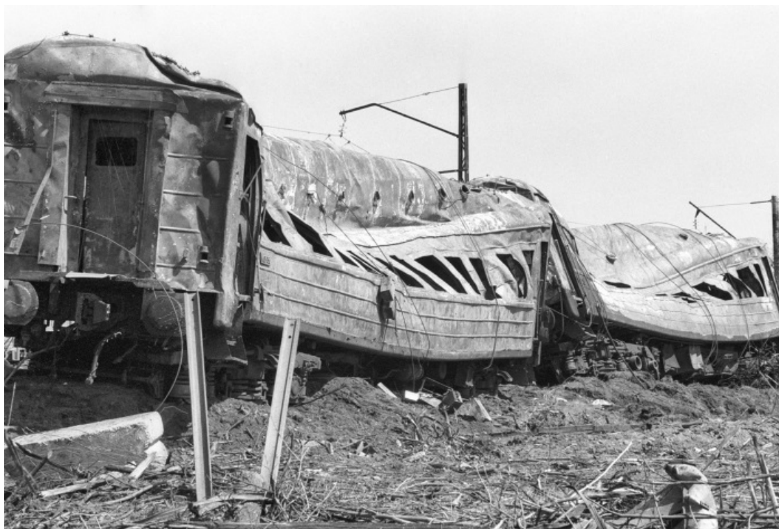
1710-й километр Транссибирской магистрали после катастрофы, 1989
