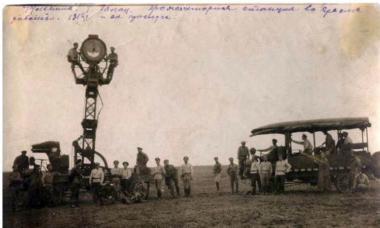
Прожекторная станция во время работы 4-й Сибирский корпус. Румыния, г. Галац, 1916 г. (Из коллекции Новосибирского краеведческого музея)
